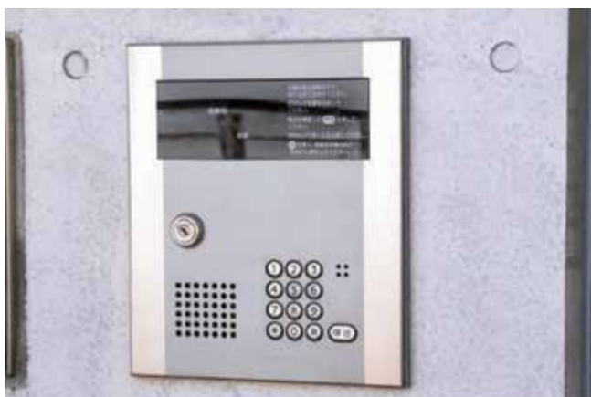
エントランス集合玄関機 リニューアル前
